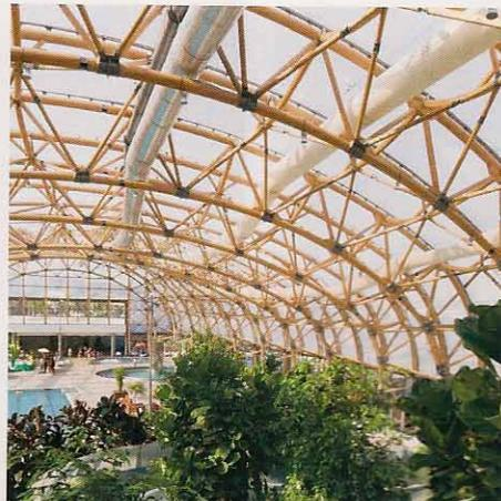
La cubierta se apoya en una estructura tridimensional, en forma de ola, a base de arcos variables formados por barras de madera laminada y encolada de sección circular. Se ha escogido una madera autóctona llamada méléze porque ofrece un buen comportamiento en ambientes acuáticos.
